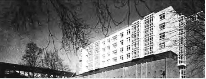
Ansicht mit aufgestocktem Bettenhaus 1995
