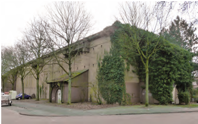
Ansicht von der Wörthstraße 2013
