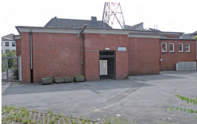
Im Hof gelegen: Haupteingang zum Technikbunker mit Funkmast 2013
