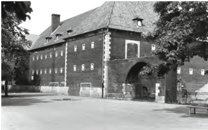
Kurz vor dem Abriss: Westansicht 1999
